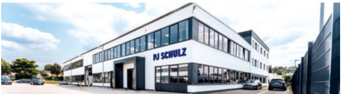
In Bergisch Gladbach kann P.J. Schulz über eine deutlich gewachsene Betriebsfläche verfügen
